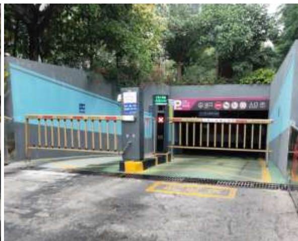
地下车库截水沟 2#
