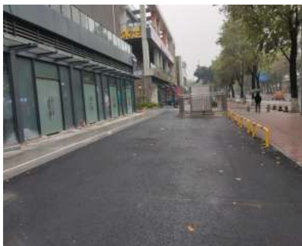
西侧硬化地面 2#
