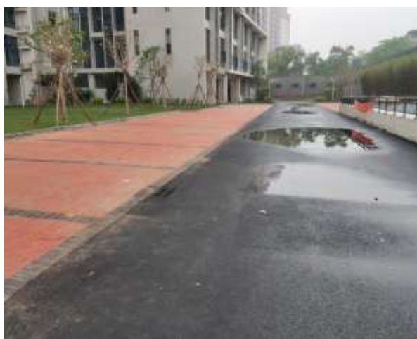
场地内部硬化地面 4#
