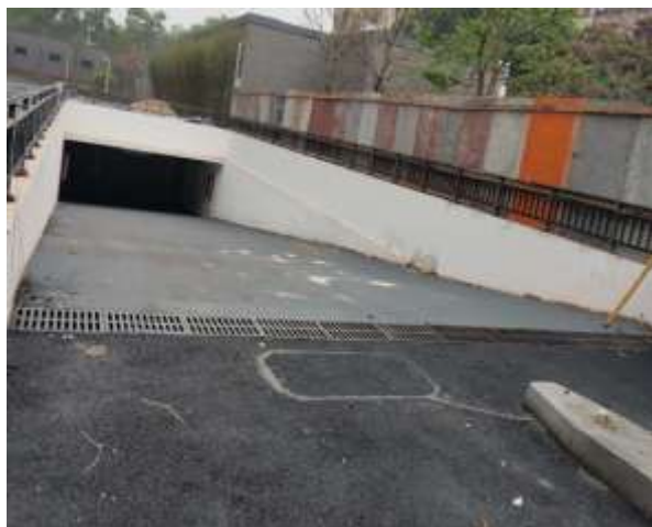
地下车库截水沟 1#
