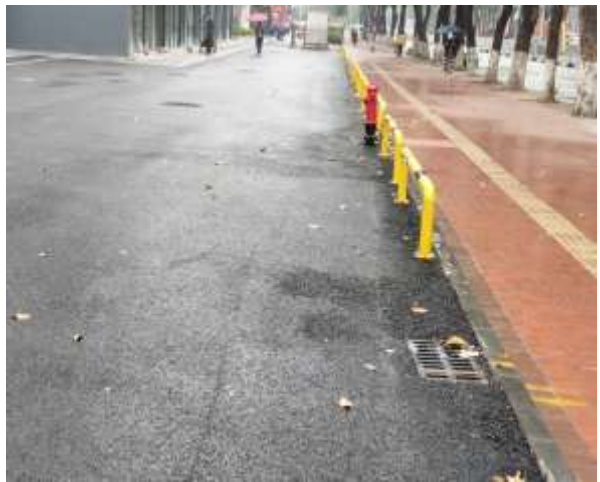
西侧排水管网 1#
