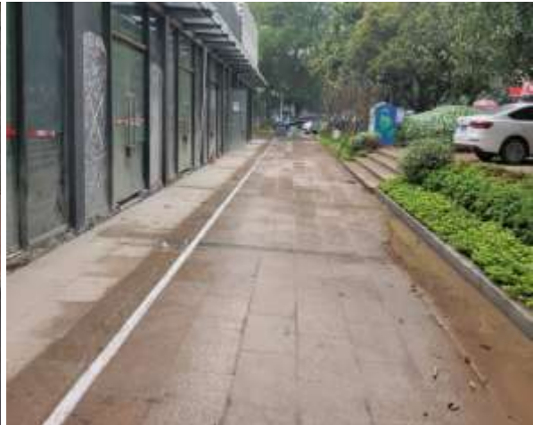
北侧硬化地面 3#
