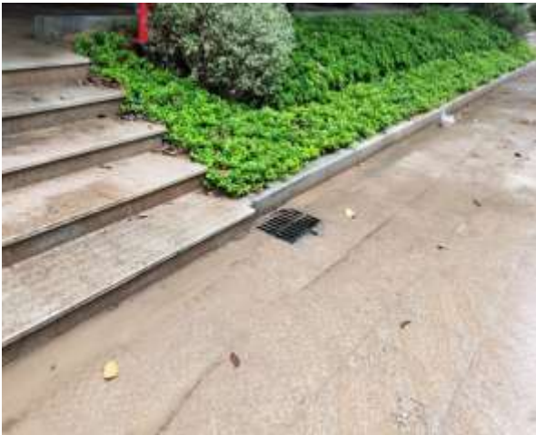
北侧排水管网 2#
