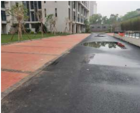
场地内部硬化地面 4#
