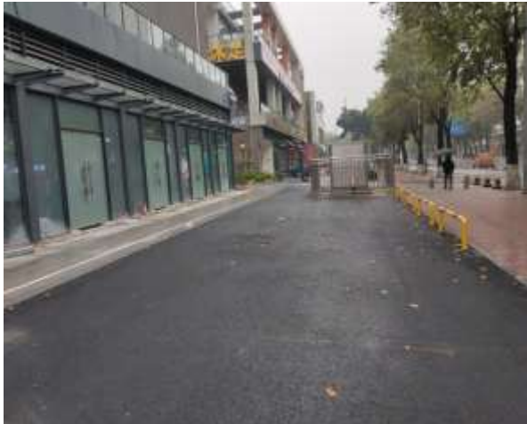
西侧硬化地面 2#
