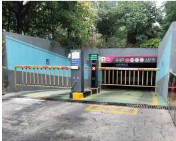
地下车库截水沟 2#
