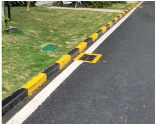
场地内部排水管网 3#
