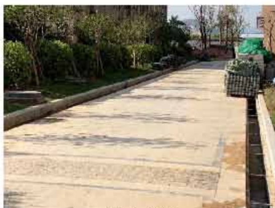
硬化小区道路
